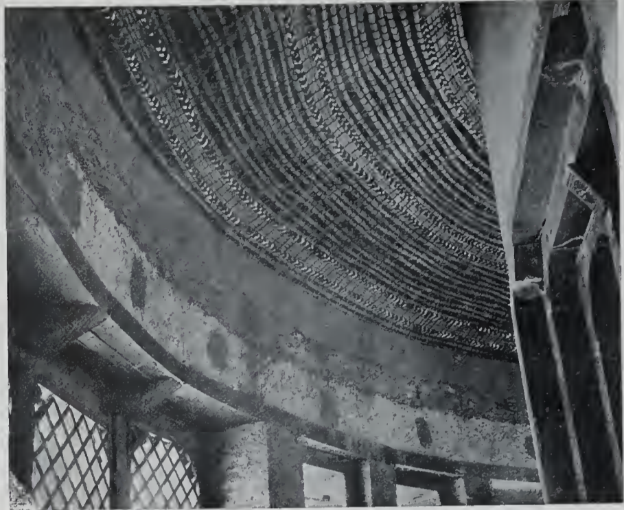
Abb. 167. Decke in der Vorhalle der Kirche des Erlösers der Welt zu Adua.
